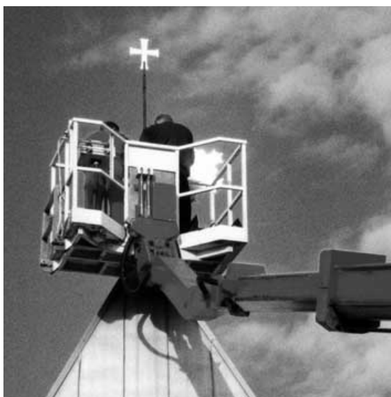
Ein erhabener Moment: Mittels Hub- bühne wird der Turmaufsatz befestigt.
